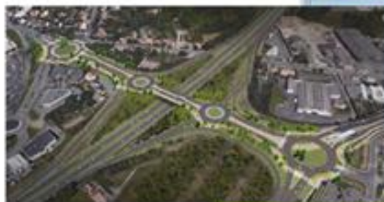
Aménagement de la porte de Rezé
